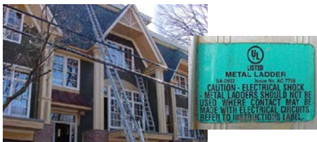
Un pintor fue electrocutado cuando una escalera metálica entró en contacto con una línea eléctrica.
